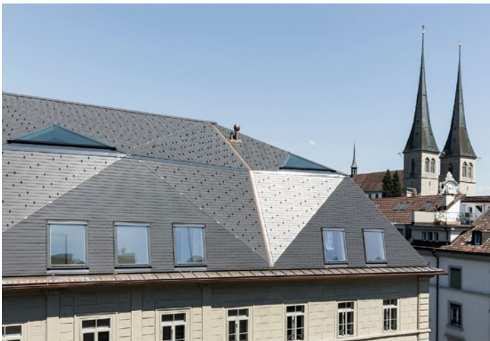
Aufstockung Löwenstrasse Luzern huggenbergerfries Architekten
