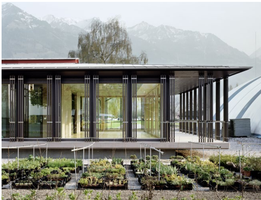
Kollegigärtnerei Sarnen Seiler Linhart Architekten
