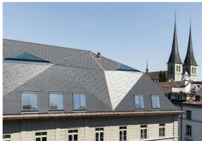
Aufstockung Löwenstrasse Luzern huggenbergerfries Architekten
