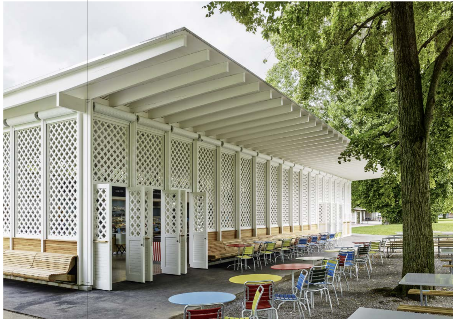
Strandbad Mythenquai Zürich Elia Malevez & Spiro + Gantenbein Architekten
